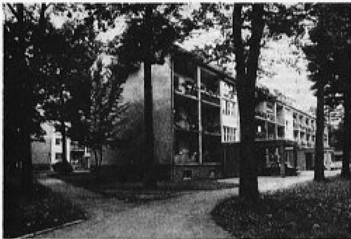
d) Stanovanjske hiše v Klđrlčevem. (Foto Stojan Kerbler)
